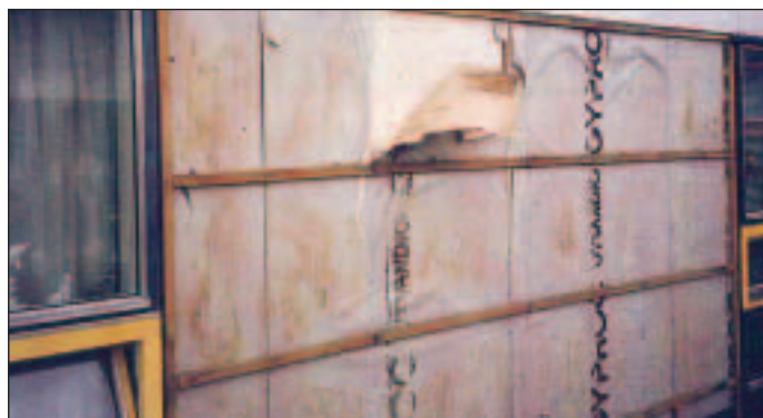
FIGUR 4 Kledning av plane plater med åpne vertikalfuger uten tilstrekkelig lufting og drenering bak kledningen. (Foto: NBI)
